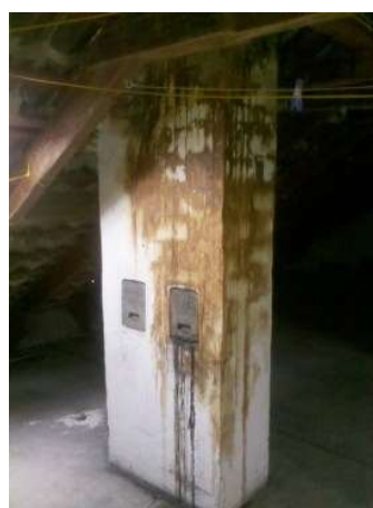
Versottungsschäden (Durchfeuchtung)
